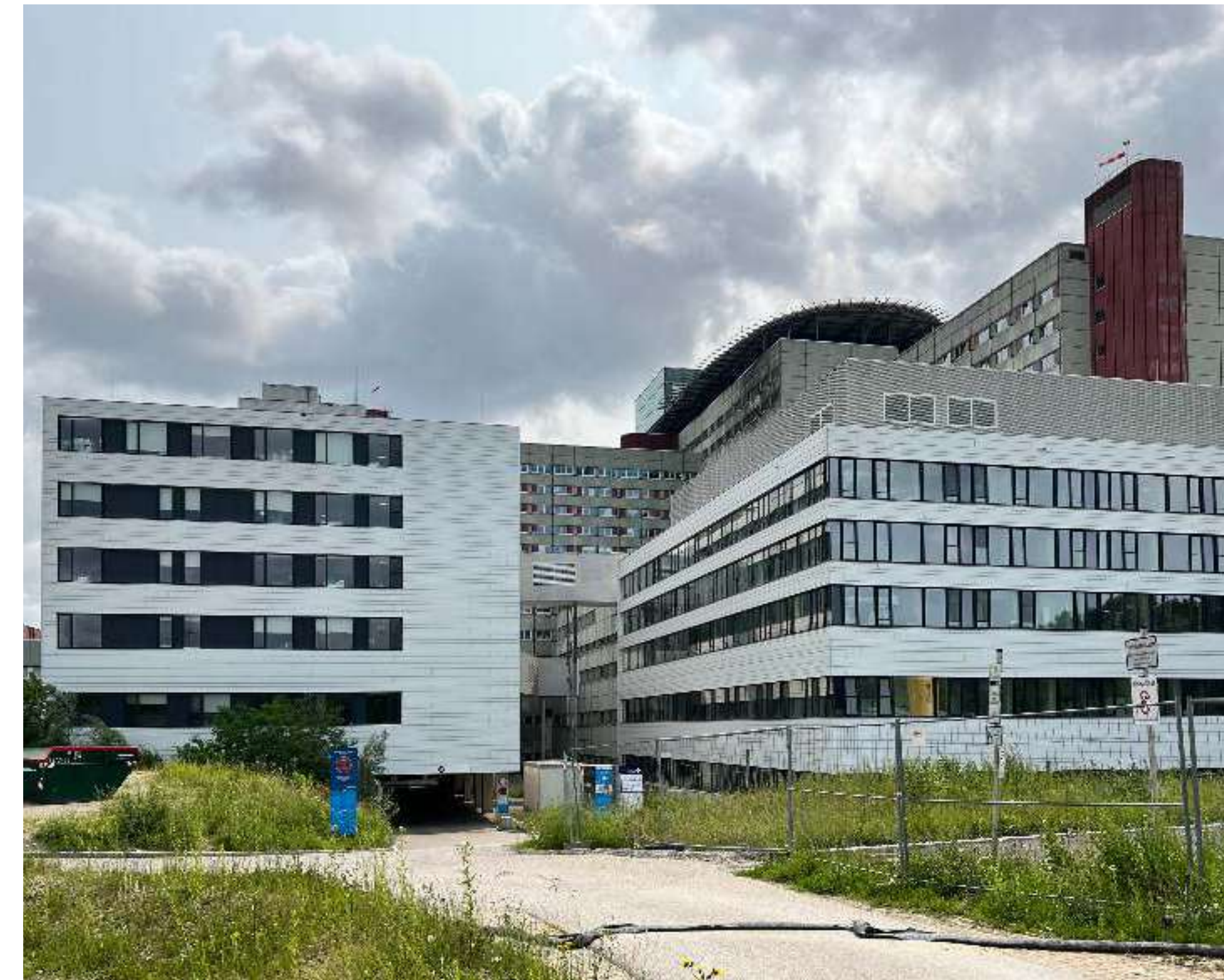
Links im Bild: Interimsbau für ursprüngliches Sanierungskonzept Rechts im Bild: Anbau „West“, östlich direkt mit Altgebäude verbunden
