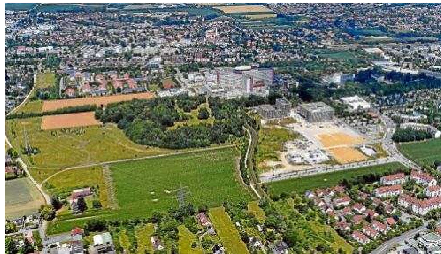
In der Bildmitte ist die Uni-Klinik zu erkennen. Auf den Feldern und dem Park links vom Bestandsgebäude soll der Neubau entstehen. Foto: Ulrich Wagner
